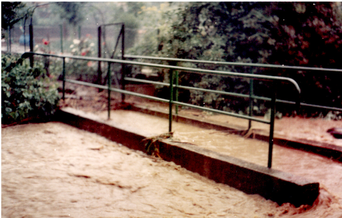
Brücke bei Stahlmann
